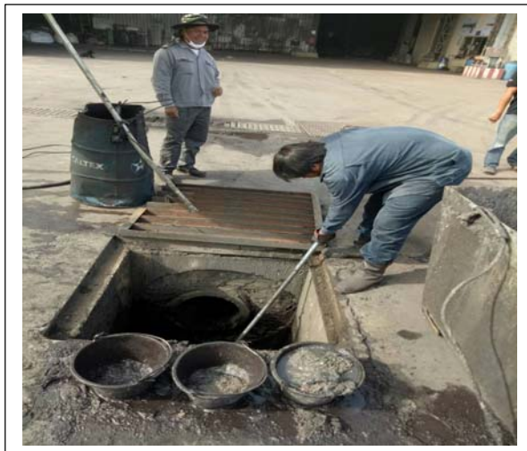
ภาพที่ 2.24 การลอกท่อระบายน้ำภายในโครงการ
