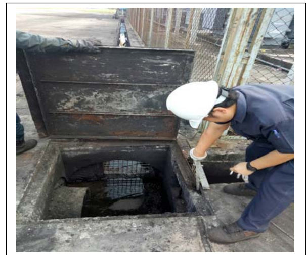
ภาพที่ 2.24 การลอกท่อระบายน้ำภายในโครงการ
