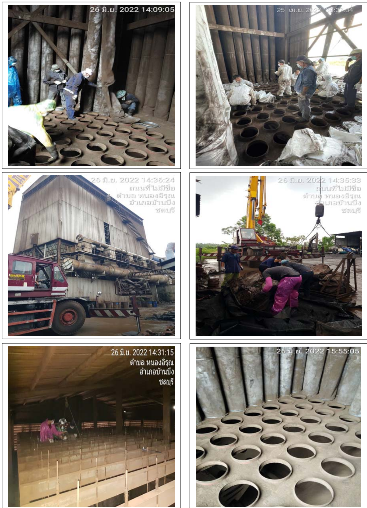
ภาพที่ 2.25 การเปลี่ยนถุงกรองจากระบบบำบัดอากาศ
